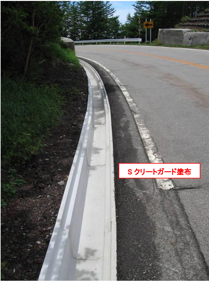
S クリートガードを塗布した側溝の様子
