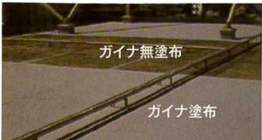
▲ RC 造建物屋上のガイナ塗布箇所とガイナ無塗布箇所の表面温度を計測。
