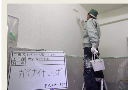
▲ガイナ施工中の様子
